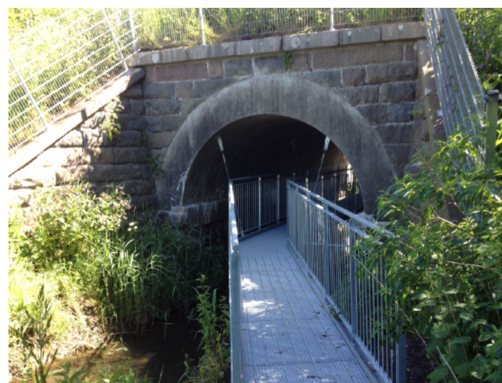
Gangbro under vandløbsbro
